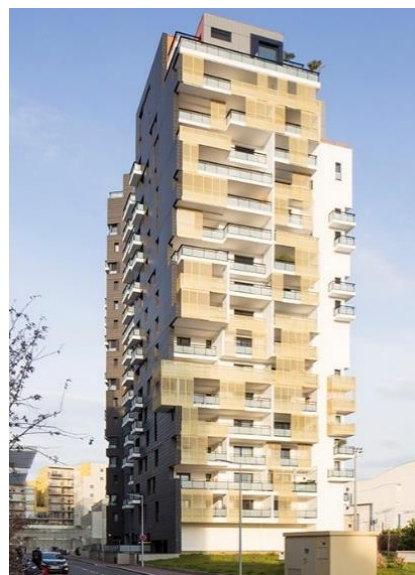
DR VMZINC® - ARCHITECTE ATELIER 2A CHRISTOPHE CHENEY PHOTOGRAPHE PAUL KOZLOWSKI
